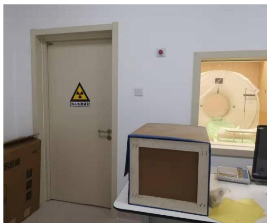
控制室工作人员防护门
